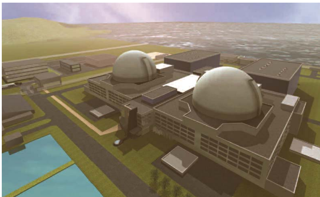
Figur 2.2. Skitse af kernekraftværk med to ACR-1000- enheder.
