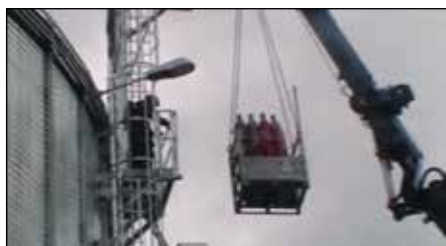
En kran hejser CO 2 -flasker op til brandfolk, der står på en platform ved foden af siloens tag.
